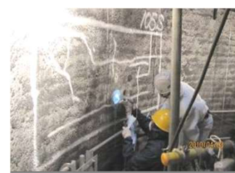
煙突の内部点検
