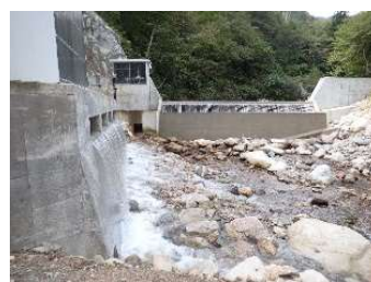
小水力発電所の建設
