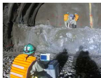
FDEMによるトンネル切羽前方探査
