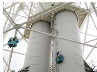
煙突の外部点検
